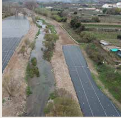
Amb la cobertura.
