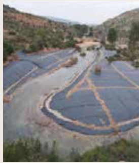
Període de permanència del geotèxtil (febrer 2020).
